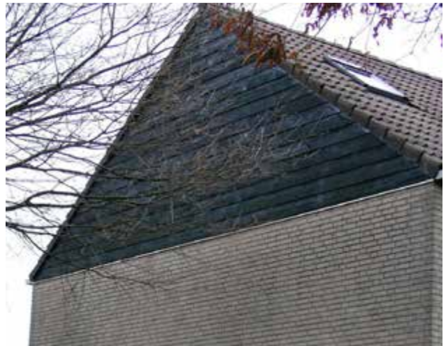
5.69 De bovenste steenlaag van deze muur van strengpersstenen is enige tijd door rosse metselbijen Osmia bicornis gebruikt als nestplaats.
