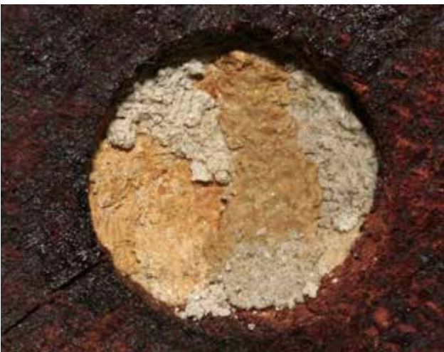
14.57 Soms wordt het materiaal van verschillende plekken gehaald, wat hier te zien is omdat elke specielading voor een ander stukje van de afsluiting is gebruikt en in kleur verschilt.
