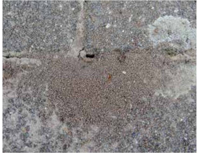
5.31 Bij mieren nesten wordt het zand korrel voor korrel naar buiten gedragen en dat geeft een ander beeld dan de vorige foto.
