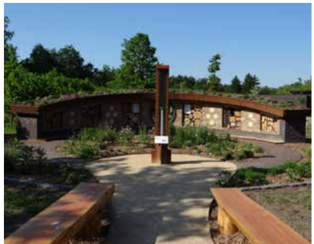
6.79 Insectenmuur met schuin oplopend sedumdak in Budel-Dorplein.
